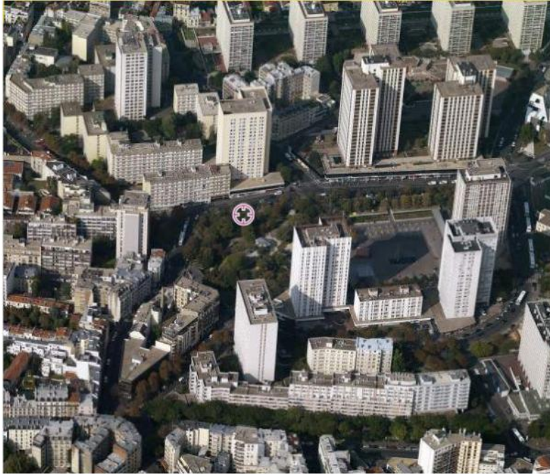
Figure 28 : Vue aérienne sur les grands ensembles de Place des Fêtes
