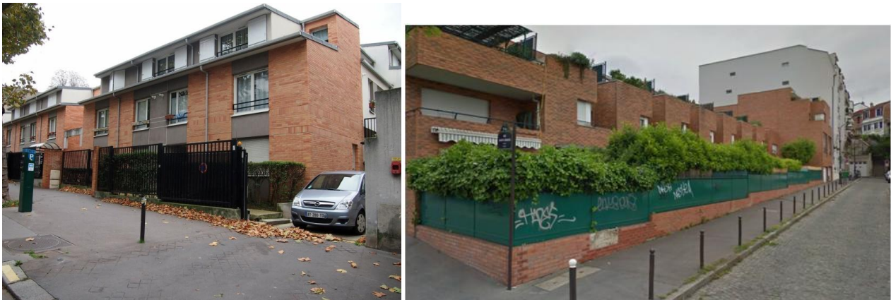
Figure 20 : Un exemple de "nouvelles" villas (type 3) au sud de la rue David d'Angers source : Anais Oddoux et Raphaëlle Hakim
