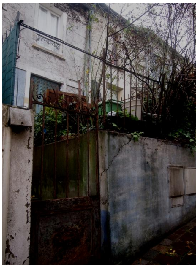
Figure 19 : Une maison du type 2 qui semble abandonnée
